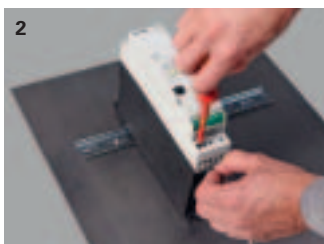
2 Připojit hlavní proudové vodiče.
